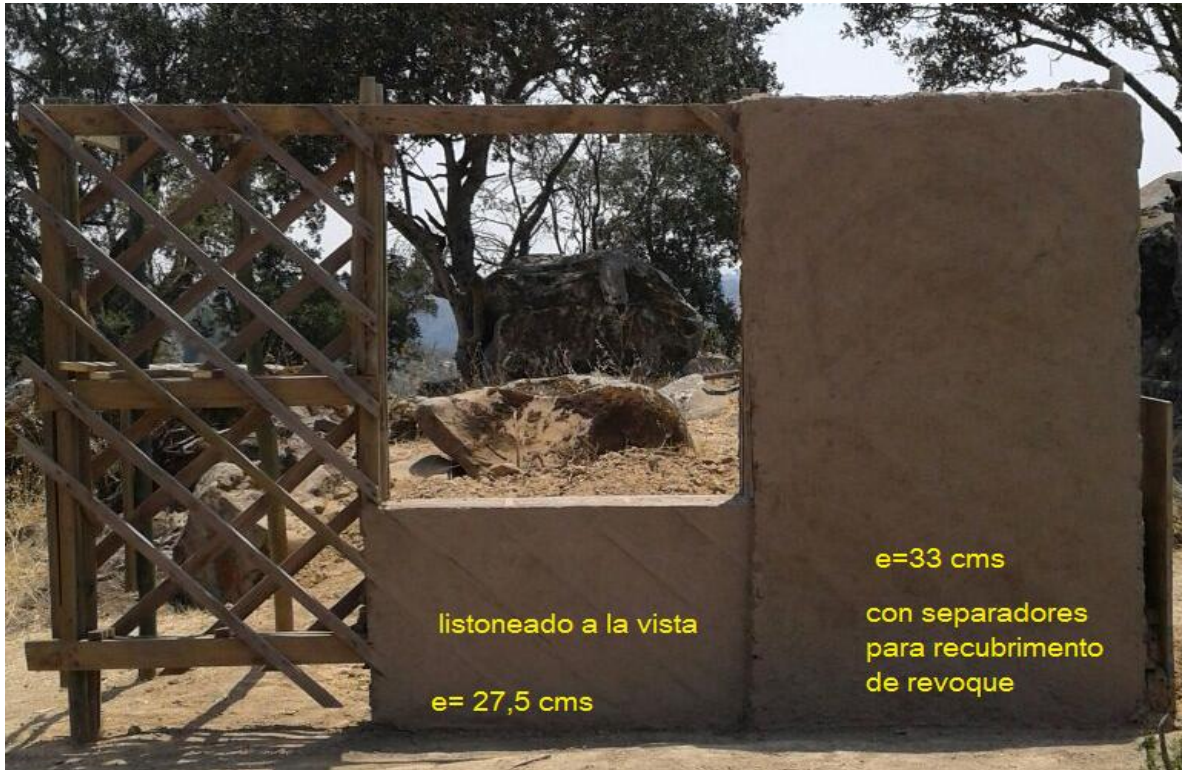
Figura 3. Imagen descriptiva del muro en elevación, en tres(3) distintos niveles de capas.
